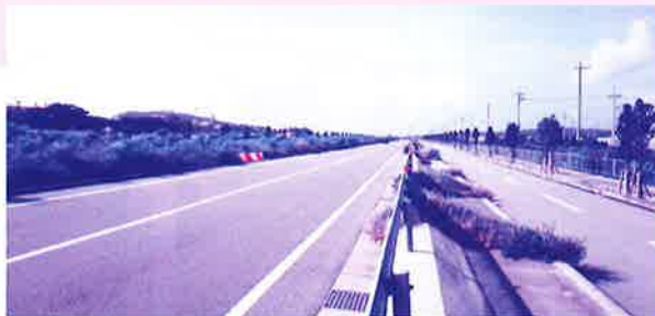
農業支援センター前の国道バイパス道路
