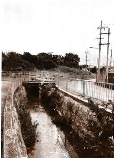
伊良皆、大湾排水路
