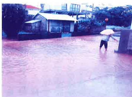
たびたび起こる村道冠水! (村道上地・座喜味線)
