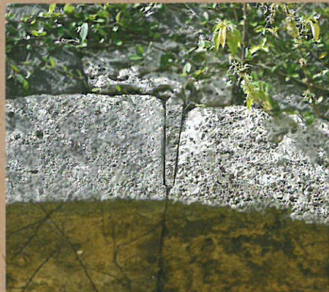
拱頂石(二層城郭的拱門) 二層城郭拱門天井的拱頂石呈三角形,一層城郭的拱頂石呈方形。
