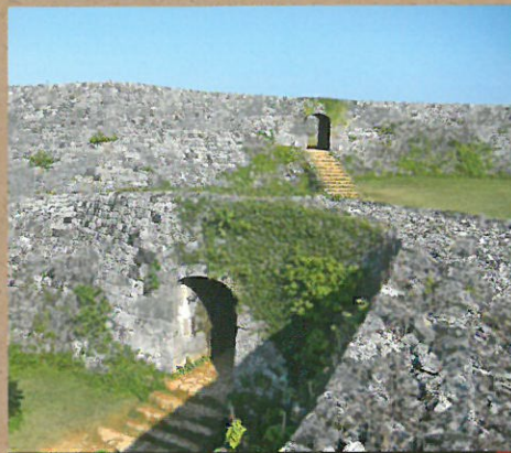
① 兩個石製拱門 一層城郭的拱門(內側)是復原重建,二層(前方的)城郭的拱門基本上是將當時的拱門修繕而成。
