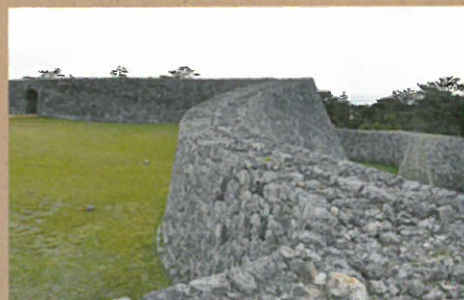
曲線狀的城牆壁 座喜味城遺跡的城牆壁與現代水庫的平面拱形構造類似,即使在脆弱的地基上也能確保堅固。可從各平面拱形的連接處監視外敵。
