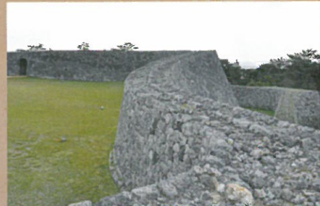
曲线状的城墙壁
