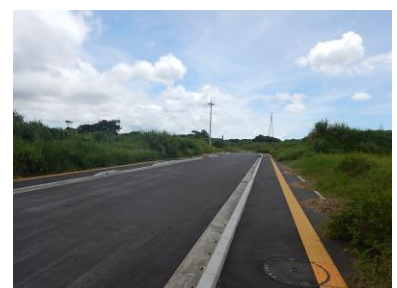
整備が進む大湾東地区の生活道路
