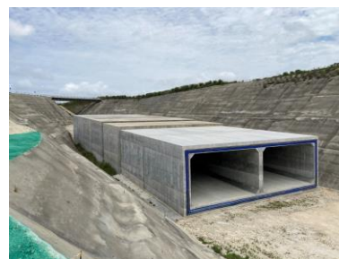
整備が進む沖縄西海岸道路 (読谷道路)
