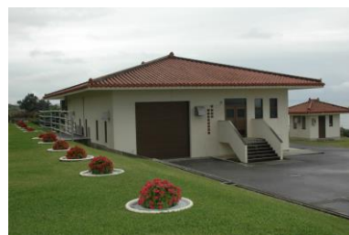
楚辺浄化センター
