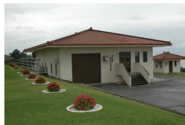
楚辺浄化センター
